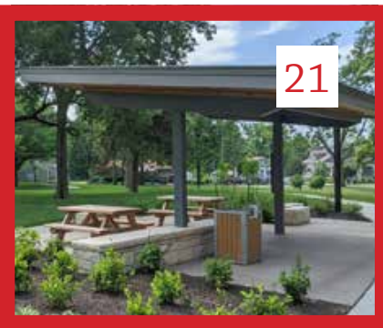
Estructura Cubierta / Covered Structure
